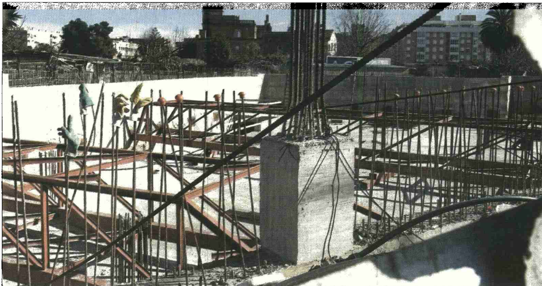
Estado de las obras paralizadas de un hotel de la cadena AC en Valencia. / BENITO PAJARES
