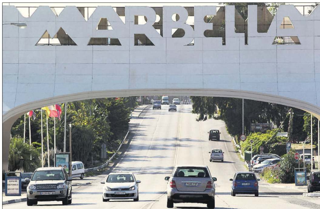
Arco de entrada a la localidad de Marbella. / GARCÍA-SANTOS
