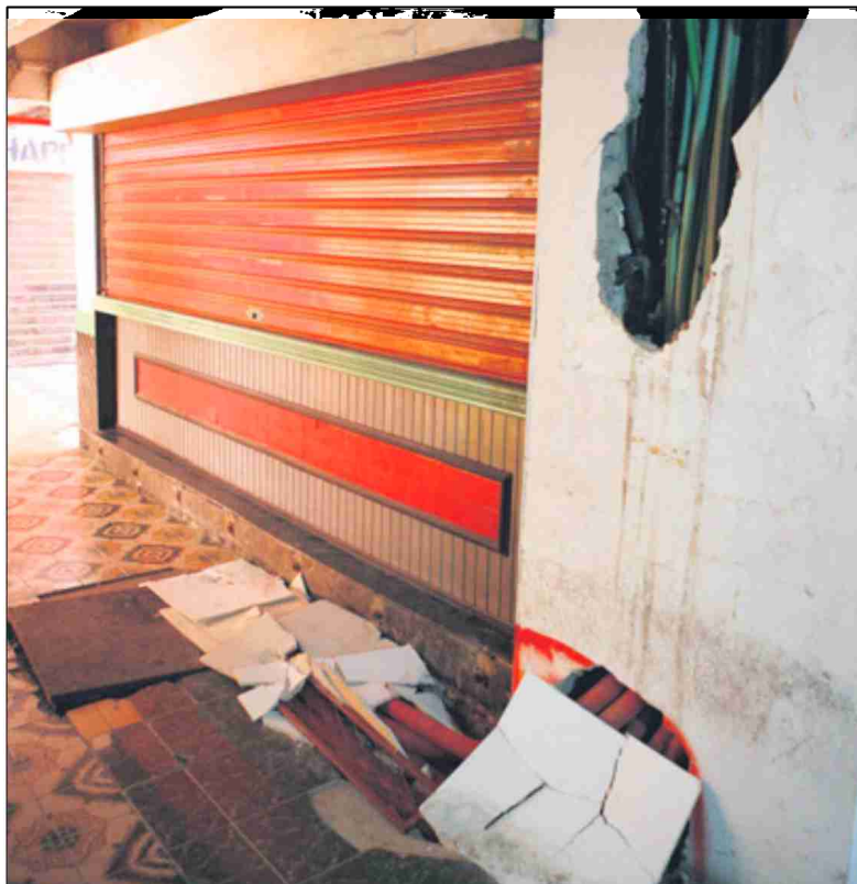
Deterioro. Imagen esta semana de un centro comercial en Playa del Inglés.
